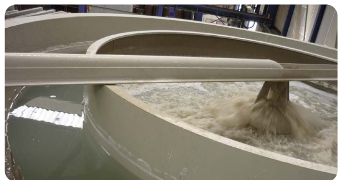
Einlaufzylinder und Ablaufrinne Inlet cylinder and outlet channel
