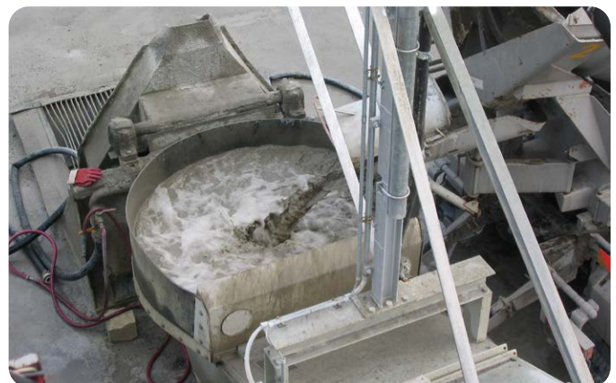
Befüllung Einlauftrichter mit Fahrmischer Filling of inlet funnel by truck mixer
